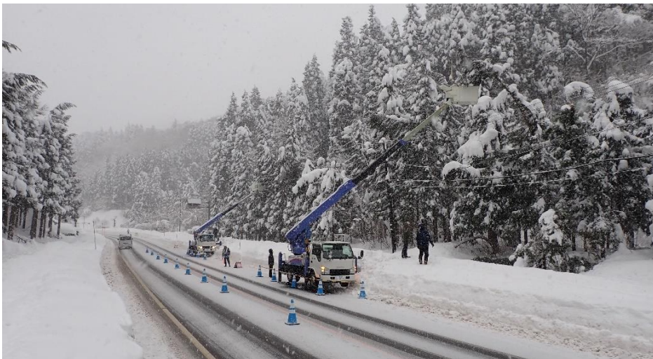
2202年12月から2023年1月 豪雪による雪害対応 配電線路伐採工事
