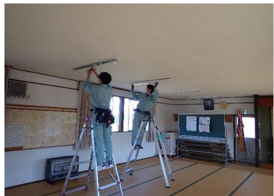
照明器具の取替工事
