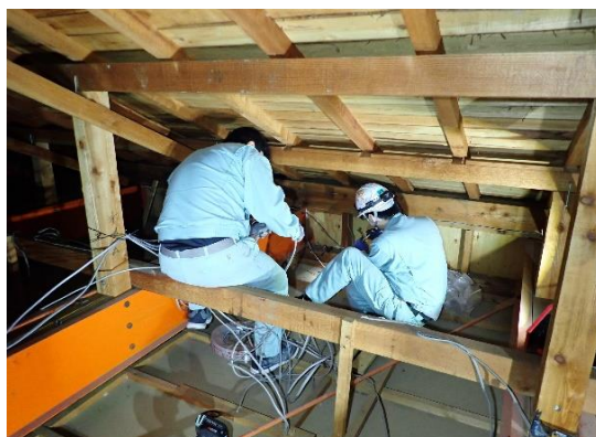
天井裏の配線工事
